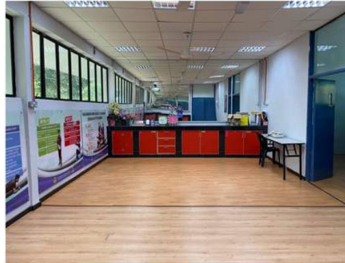
WH Pekan : Penggantian Lantai Vinyl di Bilik Aerobik
