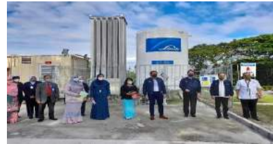
Projek Naik Taraf Bekalan Gas Perubatan di Pusat Kawalan Kusta Negara Hospital Sungai Buloh
